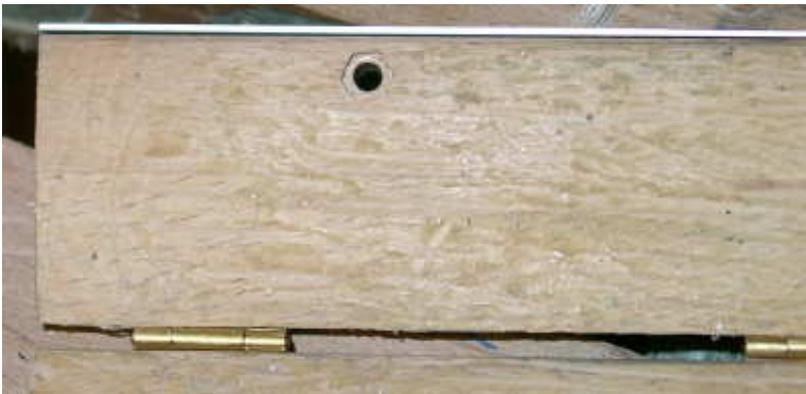
Die 5 mm Gewindeschrauben von der Holzseite her durch die Bohrungen führen und auf der anderen Seite mit den Flügelmutter (besser in diesem Fall zunächst eine Mutter mit einem Schraubenschlüssel) so fest anziehen, dass die Köpfe der Schrauben im Holz versenkt werden
