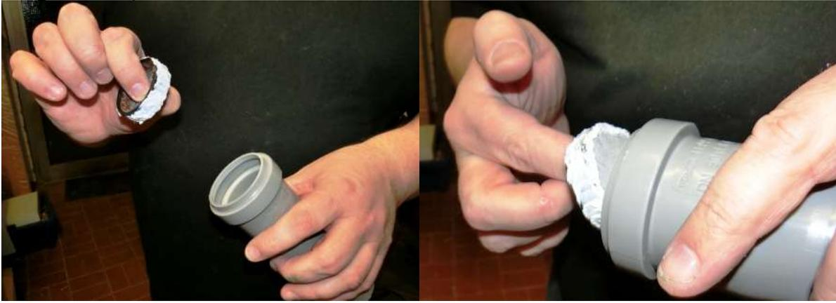
Das Ganze mit einem Spatel so verteilen, dass der Kleber die Aufnahme gut am Rohr abdichtet und zum Schluß mit dem Finger glatt streichen.
