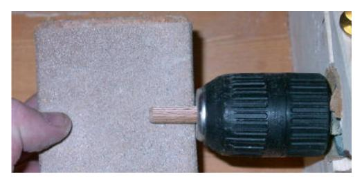
Jetzt können die Dübel in die jeweiligen Löcher der Seitenwände geleimt werden. Bei der **zerschnittenen** Seitenwand müssen nur oben tatsächlich Dübel gesetzt werden. Ich persönlich habe hier zum Schluss 4 Holzdübel gesetzt.
